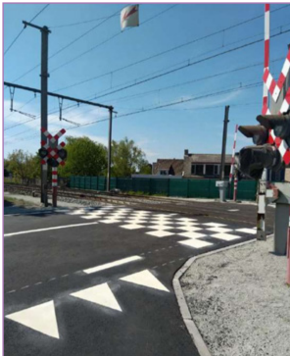
Figure 32 : marquages en damier. Source : (Infrabel, 2025c)
