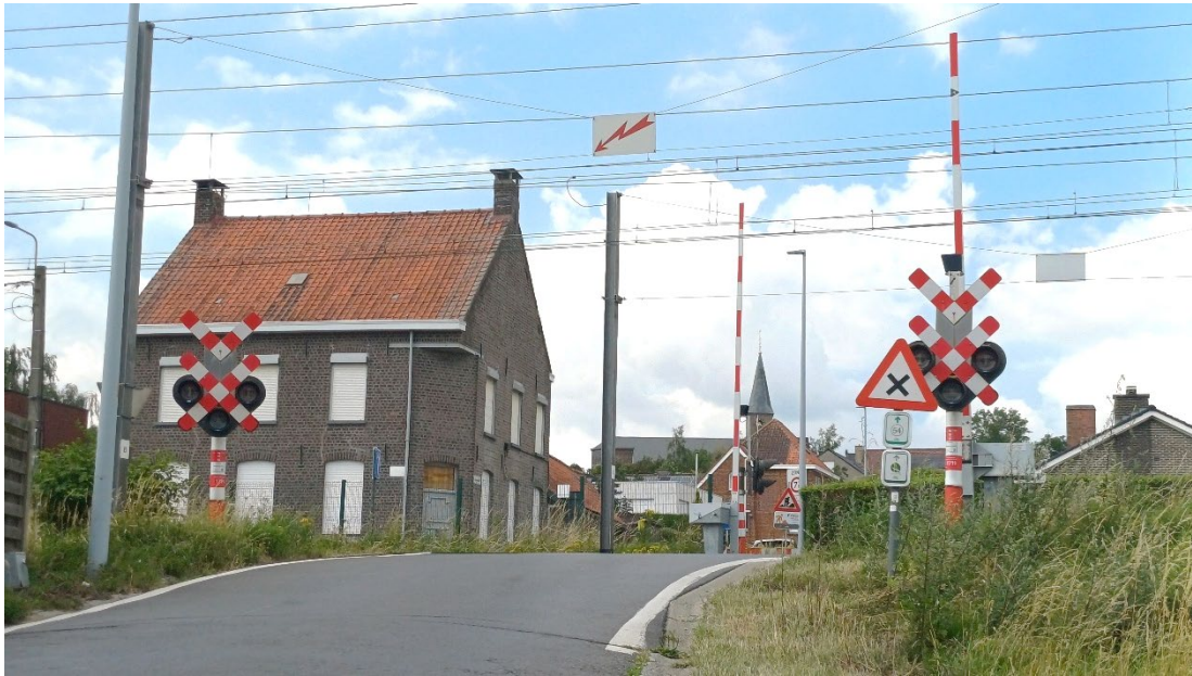
Illustratie: zicht vanuit de Broekstraat richting overweg 96. De weg loopt op naar de overweg. Het verkeersbord B17 kondigt een kruispunt aan waar voorrang van rechts geldt.
