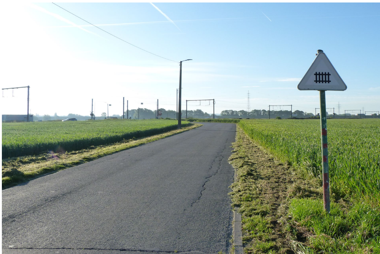
Abbildung: Gesamtansicht vom Anfahrtsbereich des Bahnübergangs Nr. 11 über die Rue de la Fournette, mit dem Gefahrenschild A41 in etwa 150 m Entfernung vom Bahnübergang (sichtbar im Hintergrund, mit den elektrischen Anlagen der Bahnstrecke)
