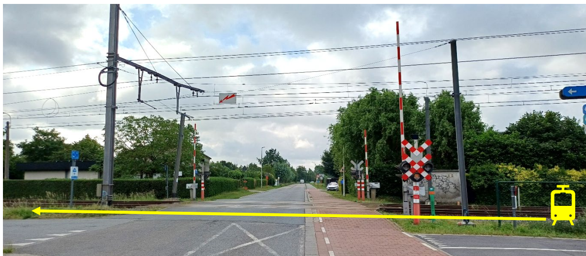
Abbildung: BÜ Nr. 60 aus der Fahrtrichtung des Lkw gesehen
