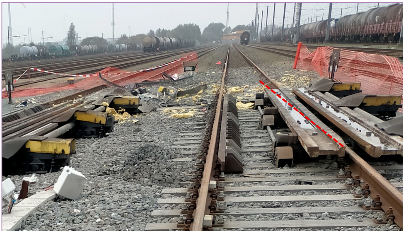
Illustration : en rouge, hypothèse du tracé de la roue droite du premier essieu du premier wagon
