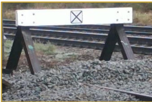
← Vb. stootbok en merkbord op het einde van een doodspoor
