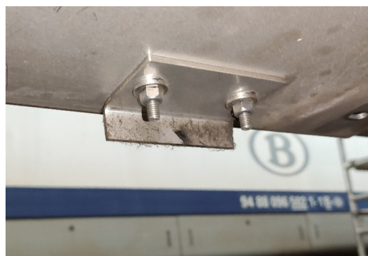
De plaat waarachter de sluitlip zich dient te positioneren.
