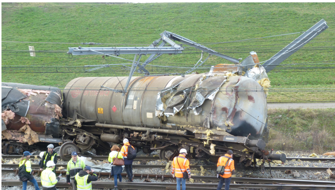
Foto: zicht op eerste ontspoorde wagon en schade aan de bovenleiding
