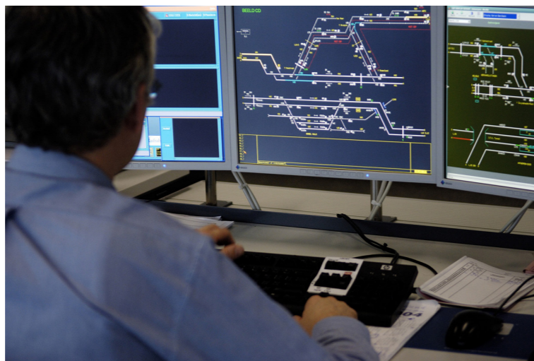
Afbeelding: gedeelte "bediening" van een elektronische bedieningspost (EBP)
