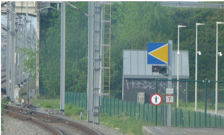
Foto: Abfahrtsignal DX-W.12 im Bahnhof Noorderkempen
