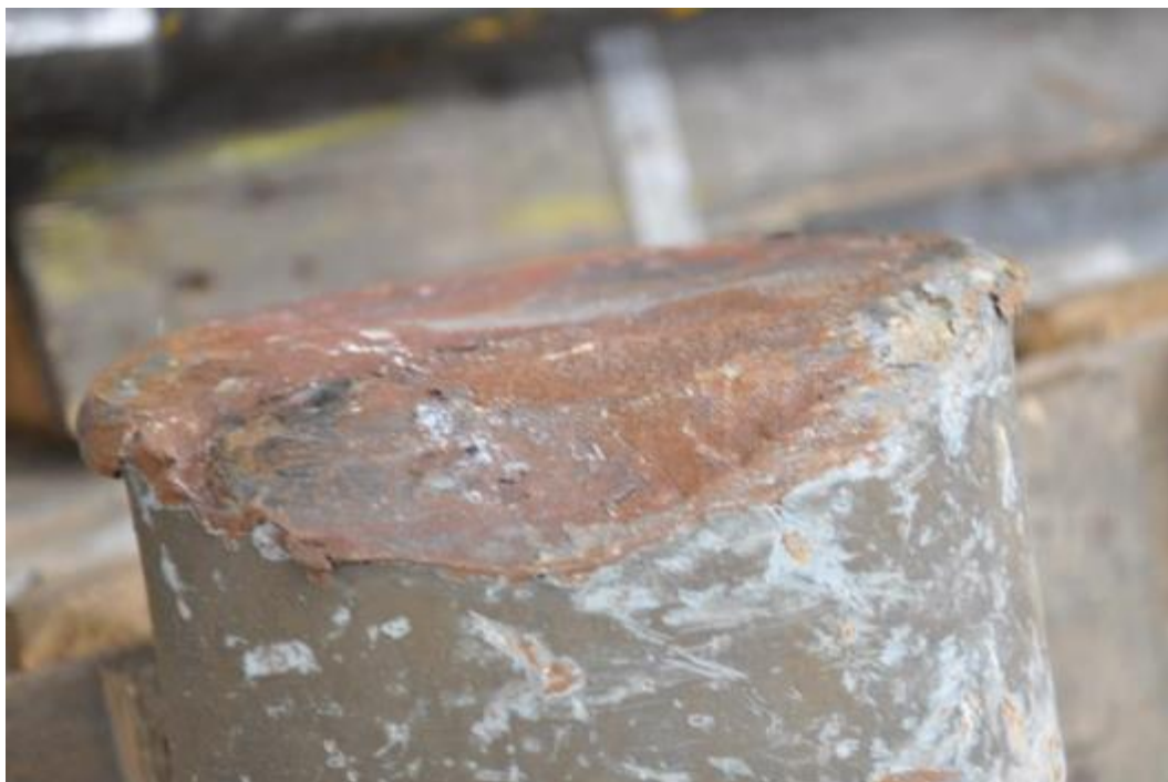
Figuur 43 : Laterale zicht van breukoppervlak aan kant B
