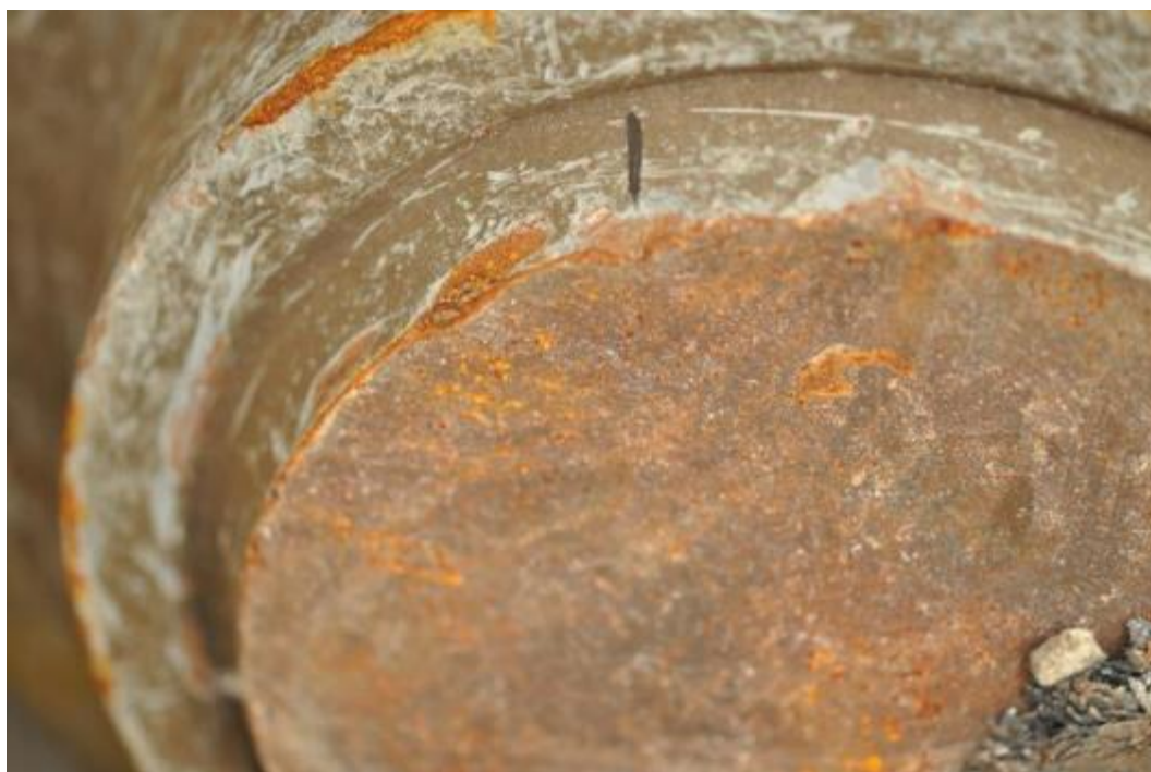
Figuur 12 : Uitzicht van breukoppervlak aan de kant van de wiel A – vermoedelijk aanzetpunt
