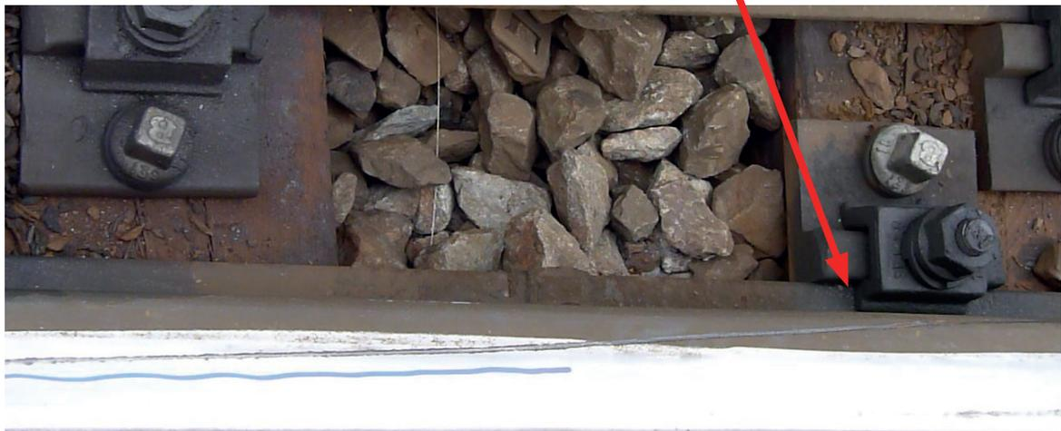
En rouge : le trajet suivi par le bogie déraillé (au lieu de suivre l'aiguillage en position droite).
